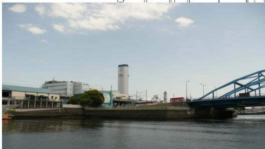
写真3 東京電力品川火力発電所（煙突の高さは114m）。
