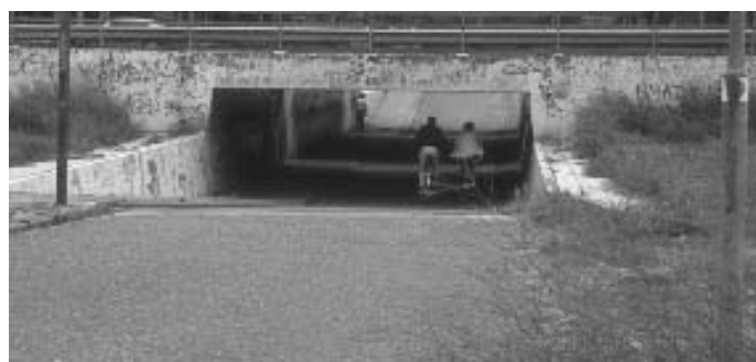
写真 - 2 幹線道をくぐる自転車専用トンネル
