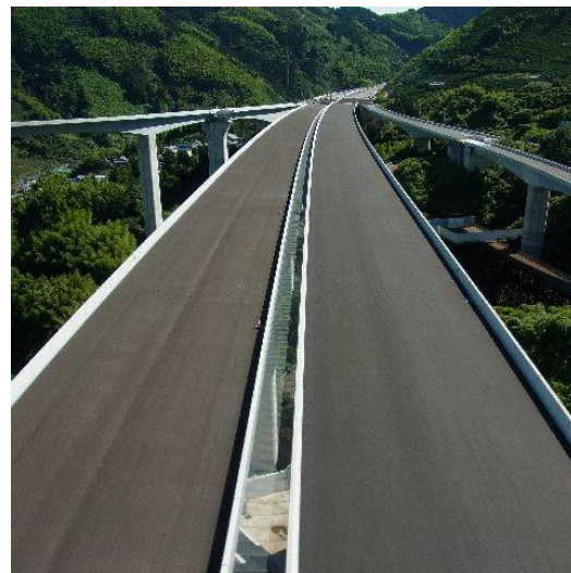
写真-1 整備の進む新東名高速道路
