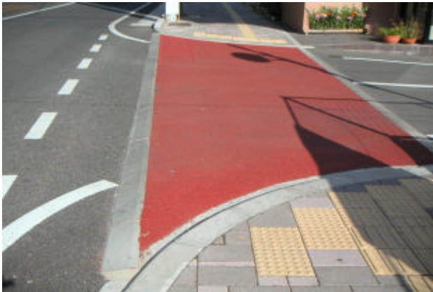
(写真-1) 駅前の歩道
