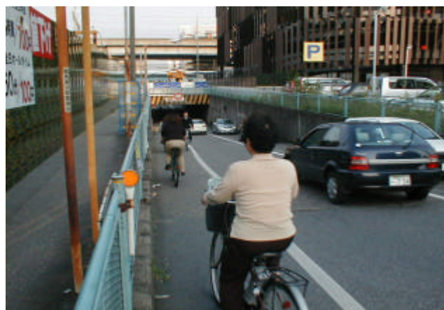
(写真-6) JRの高架部分
