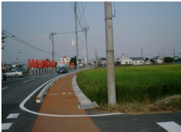
(写真-4) 田んぼ(民地)に電柱が入っている。
