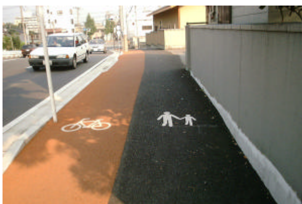
(写真-1)色分け舗装で整備された後。
