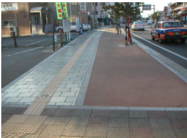
(写真-2) 市街地の整備されている歩道 色分けにより歩行者と自転車とを分離
