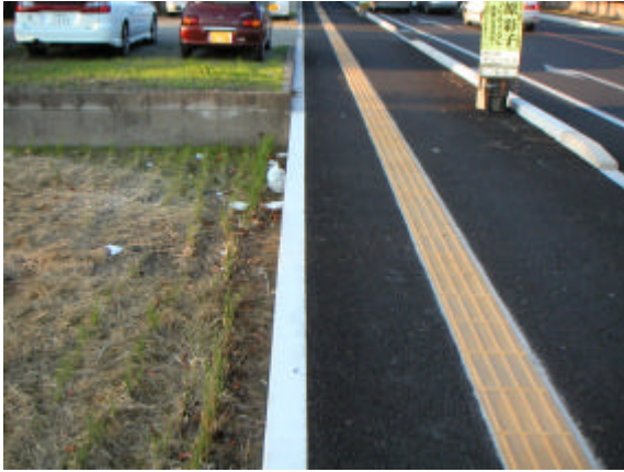
(写真-6) 整備後の歩道
