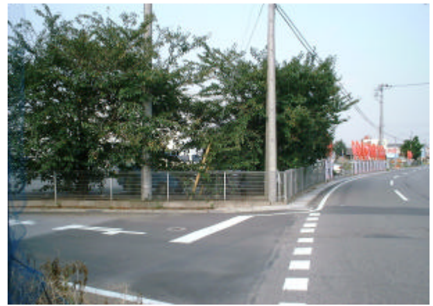
(写真-5) 道路ではなく敷地内に電柱が入っている。
