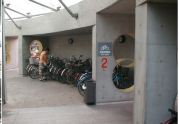
(写真-8) 市役所の駐輪場
