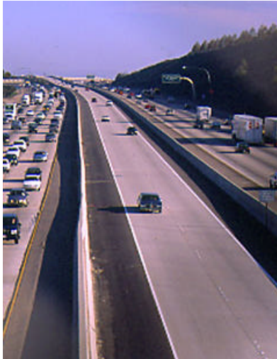
写真-5.1 I-15 の HOT レーン
