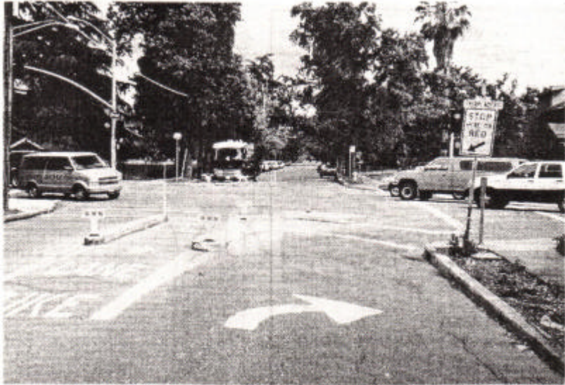
写真-6.2 直進自動車を排除する交差点 (自転車は中央の車線を通行する)
