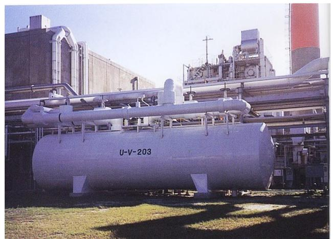
図7 蒸気アキュムレータ
