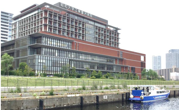
図 12 病院に給電中の小型電池船
