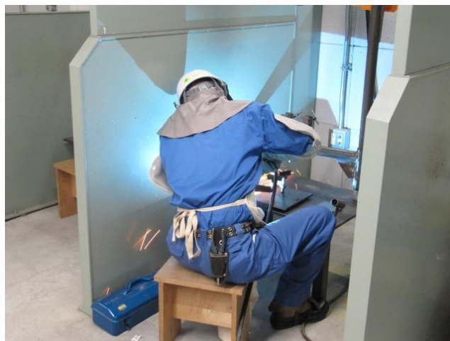
図7 EV電力でアーク溶接中
