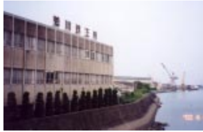
写真13 大湊に渡る湊橋から宇治山田港方向をのぞむ
