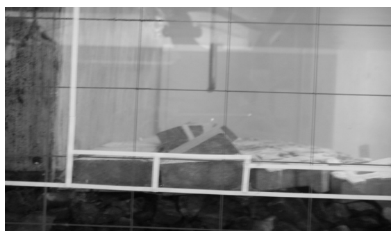
図5 ブロックの被災状況
